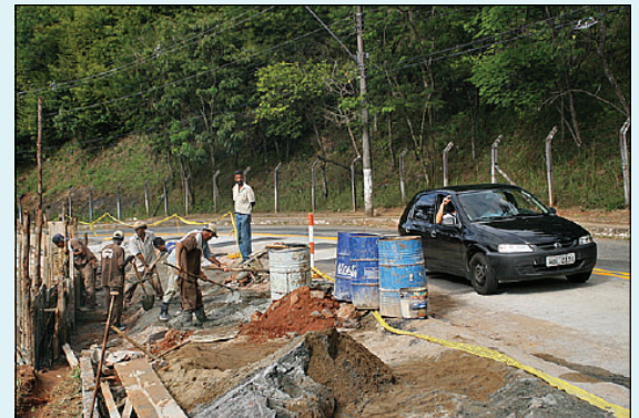
• Prefeitura ainda está finalizando os trabalhos no local
