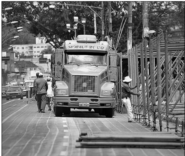
• Montagem de estruturas já começou na Avenida Brasil
