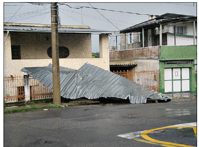
• Telha caiu sobre fios, deixando moradores do Bairu sem luz
