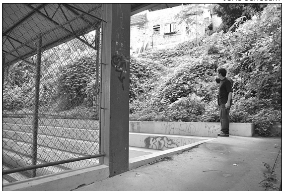
• Vice-diretor mostra locais destruídos por vândalos
